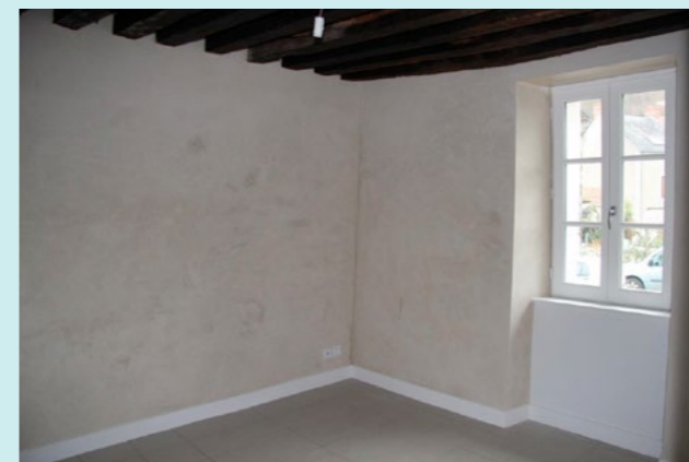
Finition par des enduits à la chaux naturelle posée sur l'enduit chaux-chanvre (Source : CREBA)
