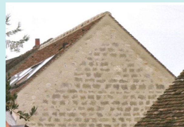
Aspect des rives après travaux, enduit à la chaux (Source : MPF)
